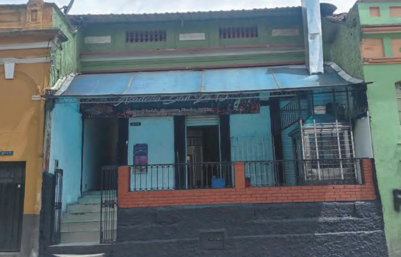
7b. Estado actual de la construcción, 2022. Imagen: John Jairo Ruiz Martínez.
