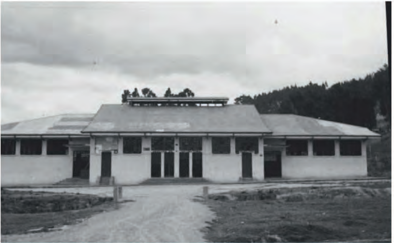
18b. Paso de la quebrada El Teñidero y la plaza de mercado. Tiempo después funcionó como inspección de policía. Imagen: Archivo de Carlos Martínez Jiménez, revista PROA.
