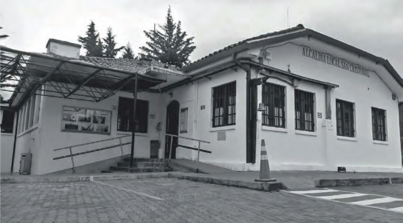
22b. Estado actual de la edificación, 2022. Imagen: John Jairo Ruiz Martínez.
