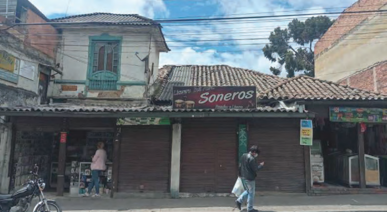
13b. Estado actual de la construcción, 2022. Imagen: John Jairo Ruiz Martínez.
