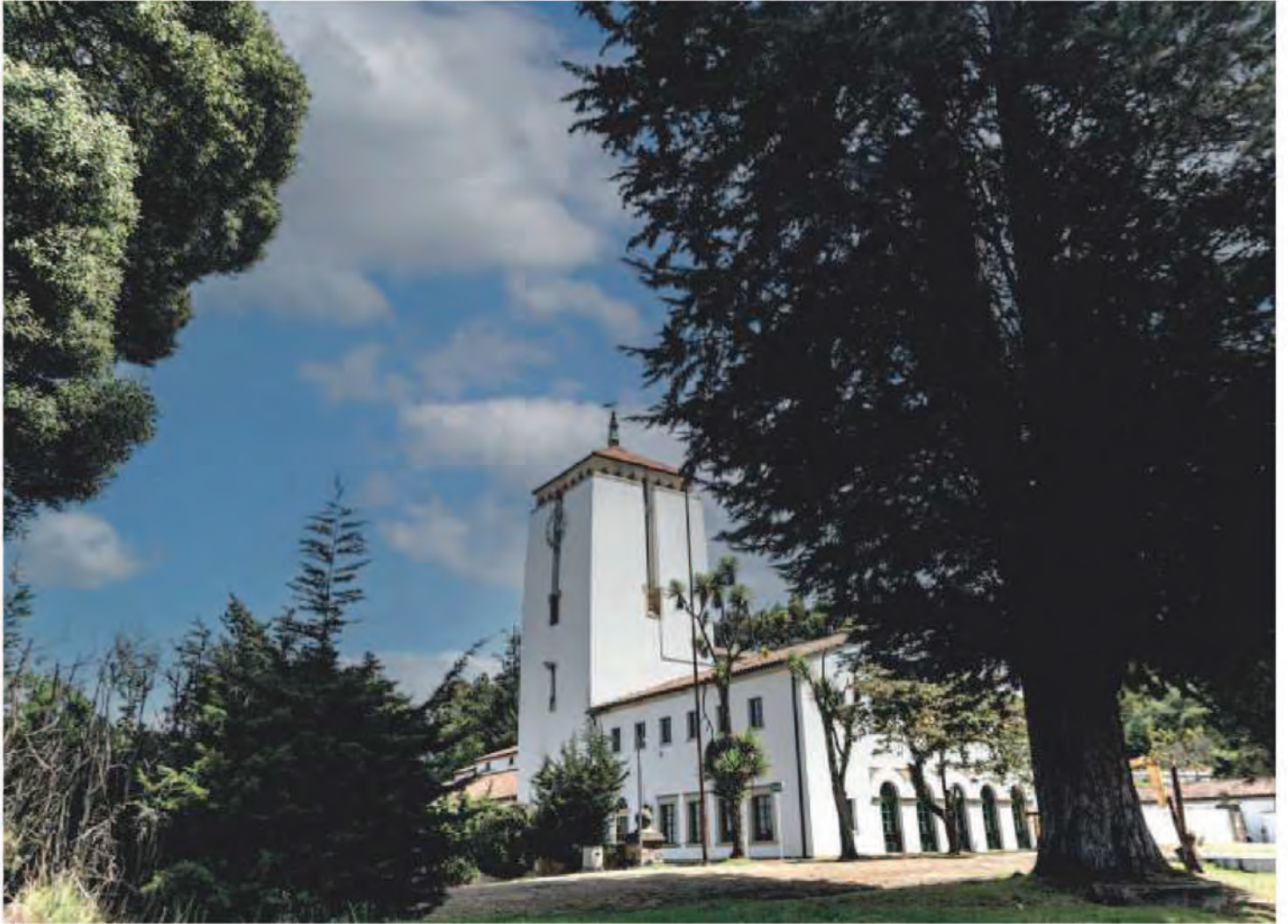
41b. Vista de la torre de la Planta de Tratamiento de Vitelma. Fuente: Adriana Salazar, 2022.
