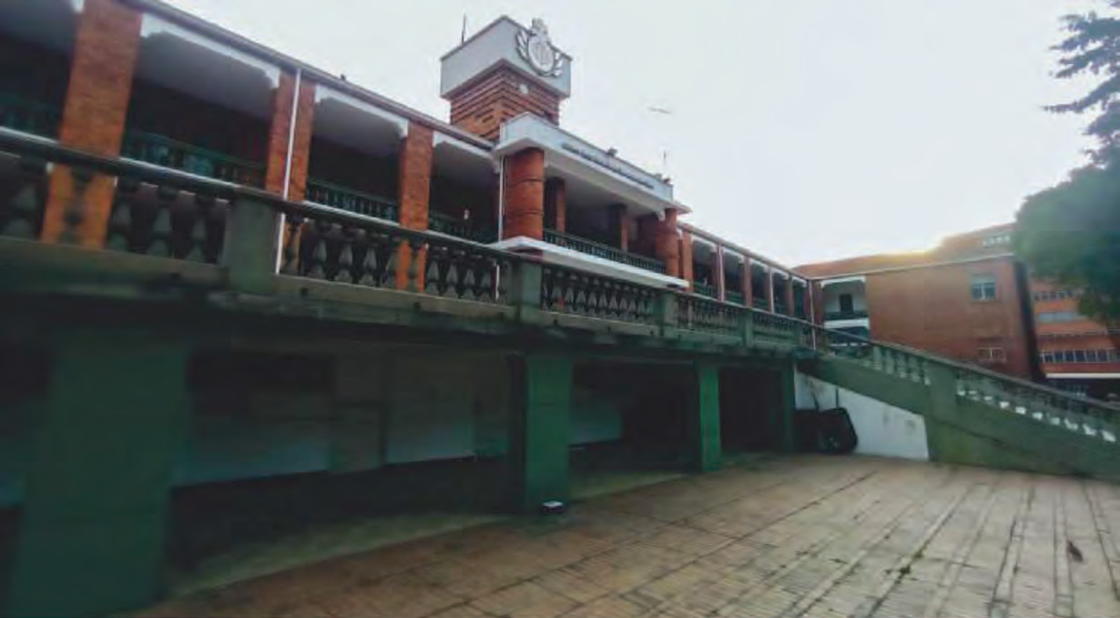
23b Estado actual de la edificación, 2022. Imagen: John Jairo Ruiz Martínez.
