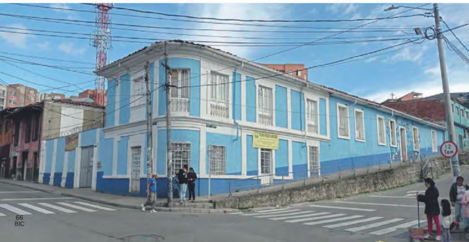
5a. Estado actual de la construcción con dos pisos, 2022. Imagen: John Jairo Ruiz Martínez.
