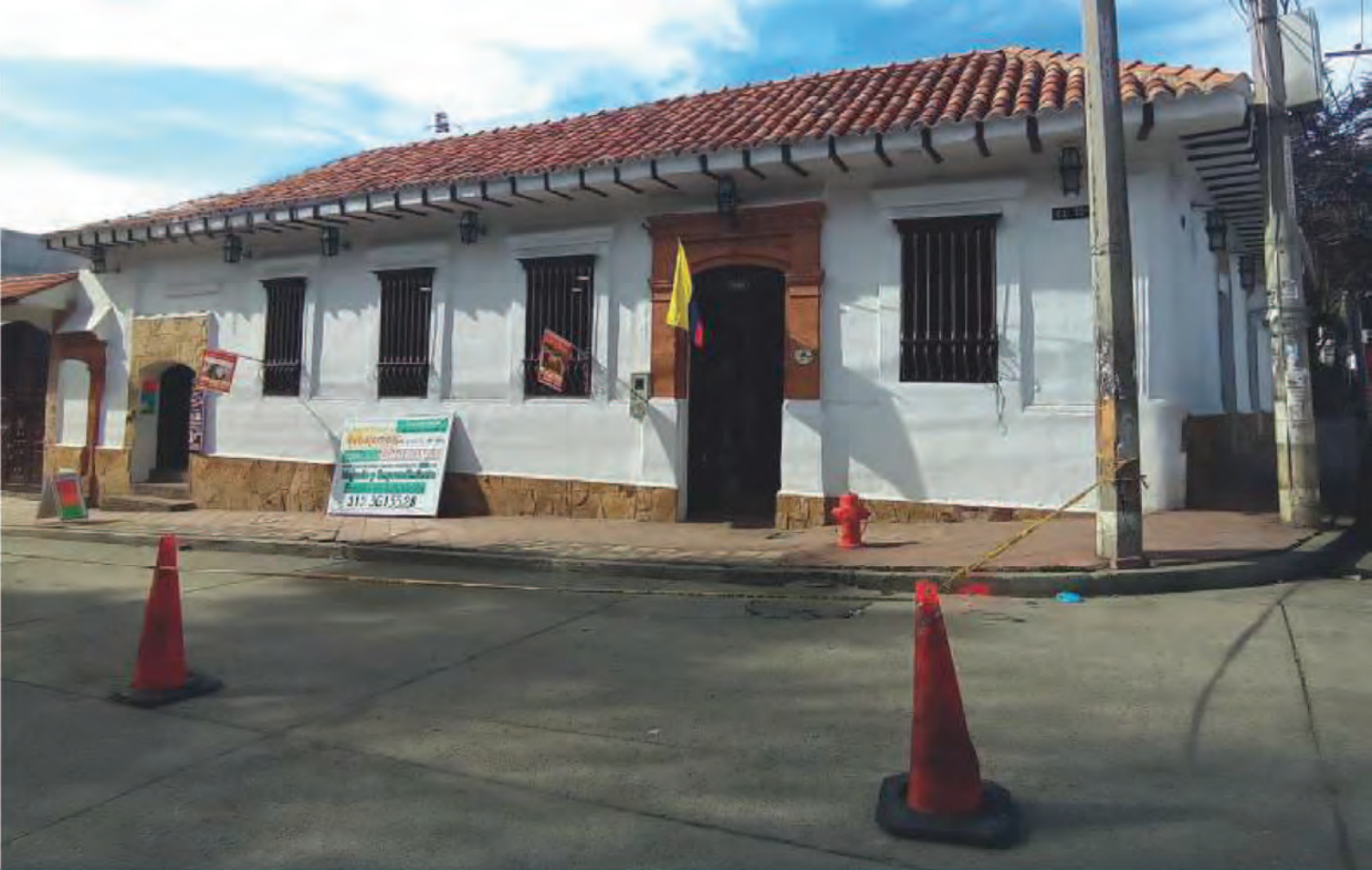
11b. Estado de la construcción esquinera de un piso, 2022. Imagen: John Jairo Ruiz Martínez.
