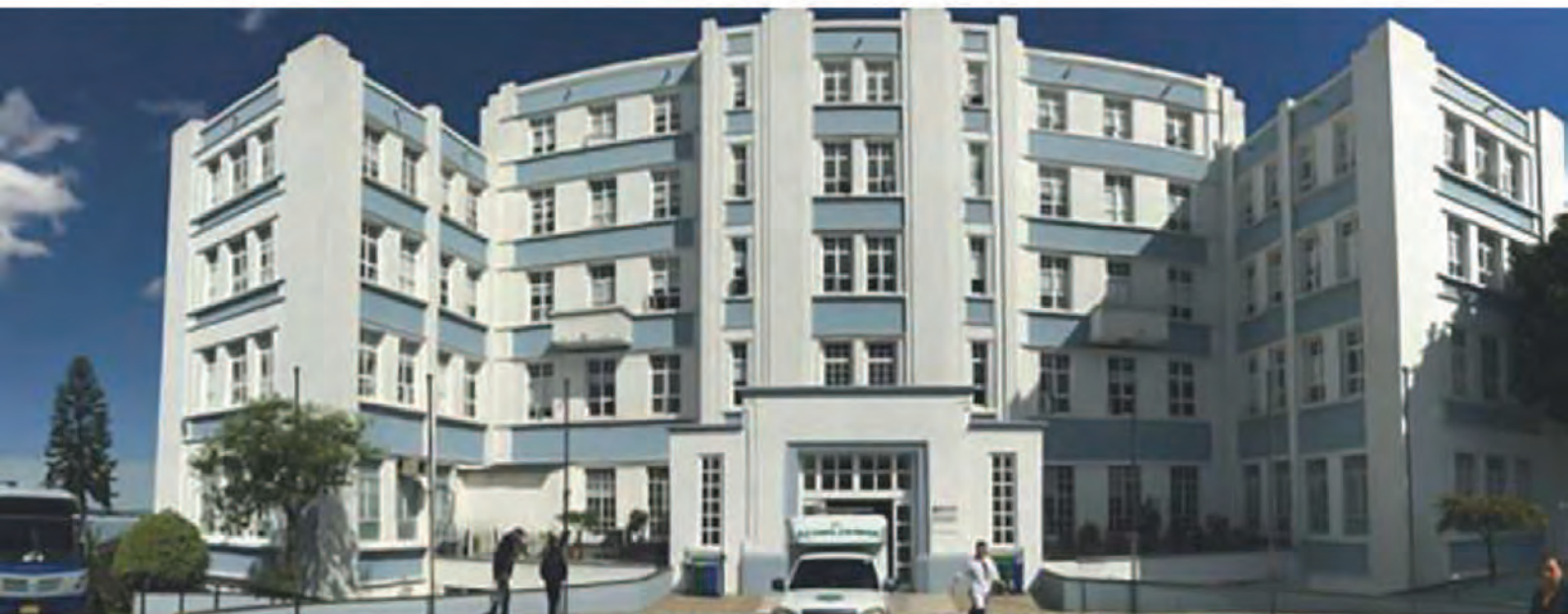
39a. Fachada principal del edificio Art Decó, 2020. Imagen: Hospital Universitario Administración.
