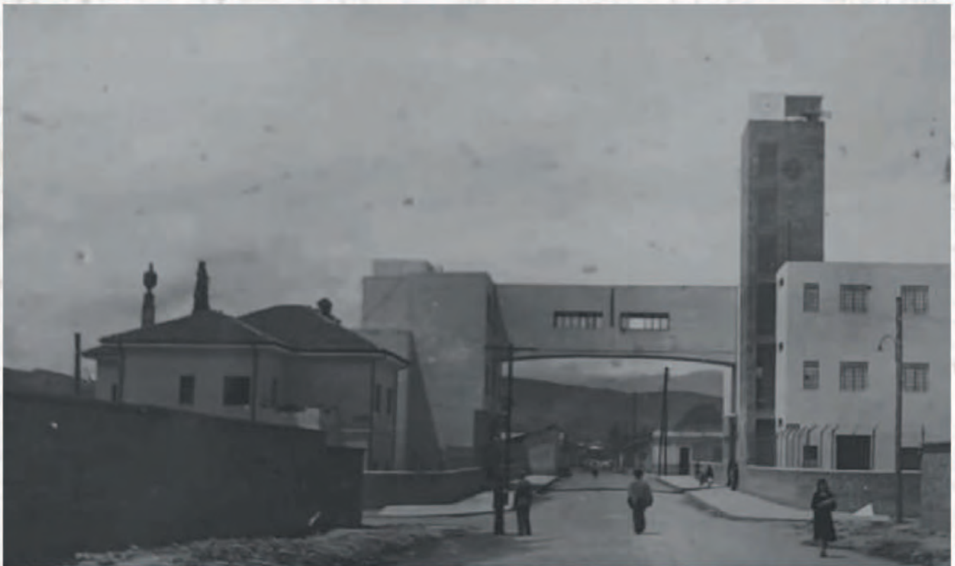
Recuerdos desaparecidos. Imagen 1: Entrada a la antigua cárcel Distrital en el sector de Calvo sur, del ingeniero Jorge Camacho Fajardo, 1937-1938. Edificación Innovadora que conservó en su momento una construcción antigua e introdujo una nueva con un paso aéreo y subterráneo. Imagen: Sociedad de Mejoras y Ornato.
