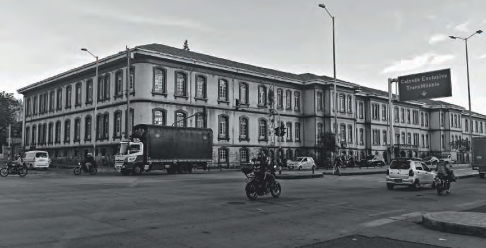
3b. Estado actual de la edificación, 2022. Imagen: John Jairo Ruiz Martínez.
