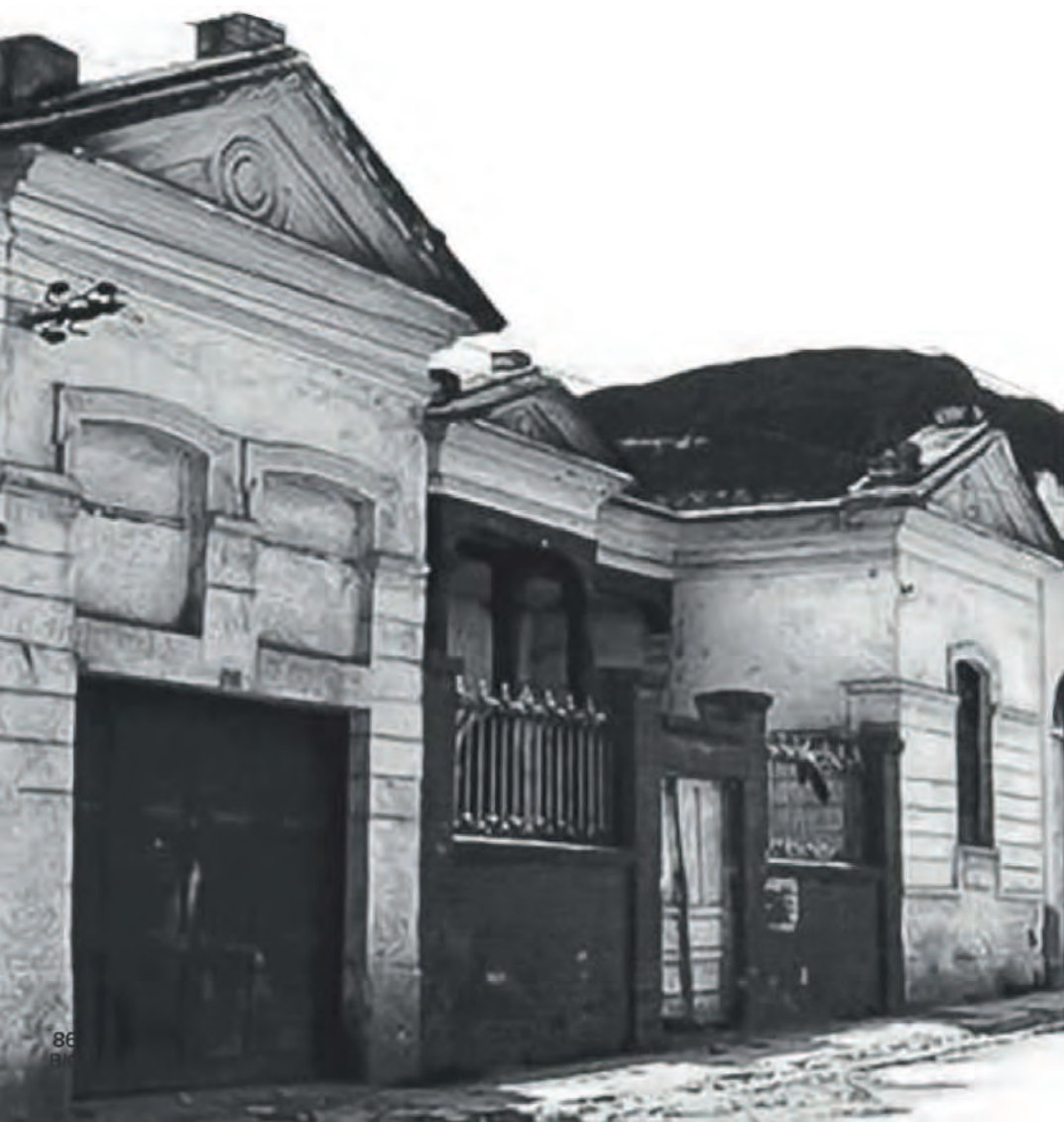
15a. Casa quinta antes de ser demolida S.F. Imagen: Archivo IDPC.
