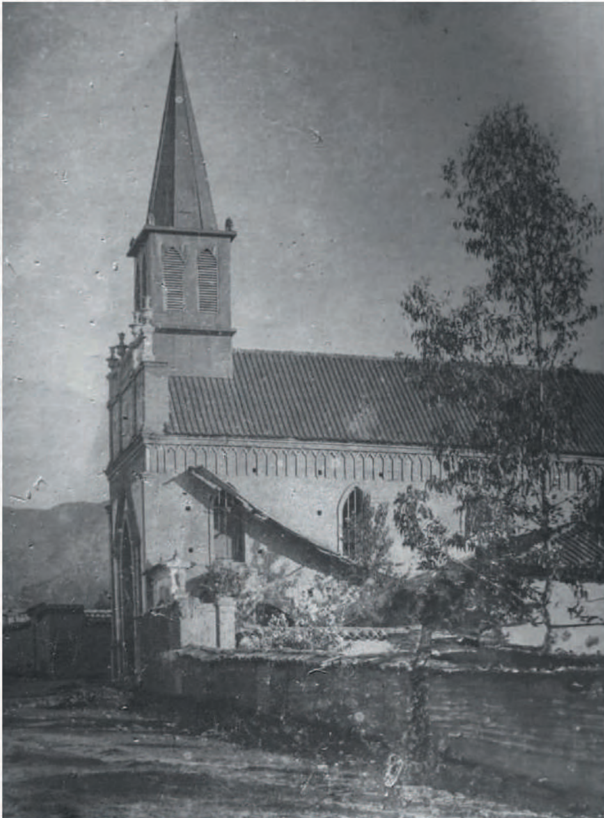
Imagen 7: Construcción de la edificación para iglesia de San Cristóbal ya en proceso de culminación, con la edificación adjunta de un piso, 1924 -1925, aprox. Fuente: Luis Pantaleón Gaitán I.
