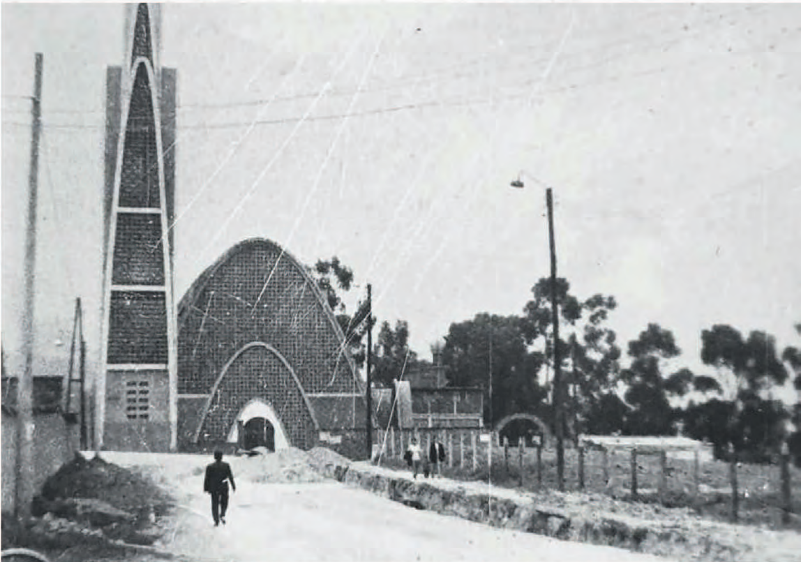
Imagen 25: Obras sobre la vía que comunica la calle 11 sur con la iglesia, finales de 1966. Fuente: Nicolás Castillo, maestro de obra de la iglesia.
