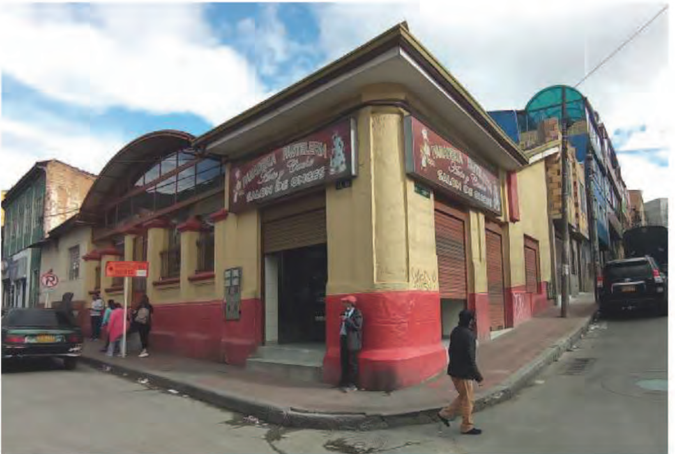
10b. Estado actual con las intervenciones sucesivas 2022. Imagen: John Jairo Ruiz Martínez.
