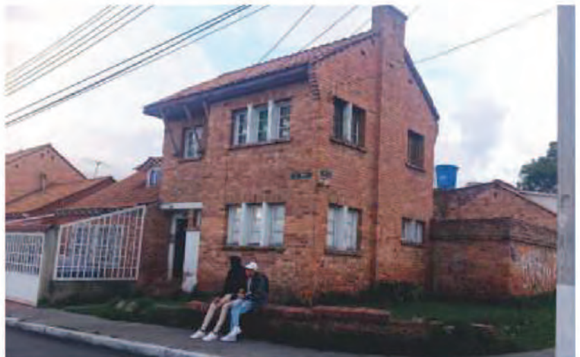
2c. Reforma realizada al urbanismo original, 1945. Fuente: Caja de Vivienda Popular.
