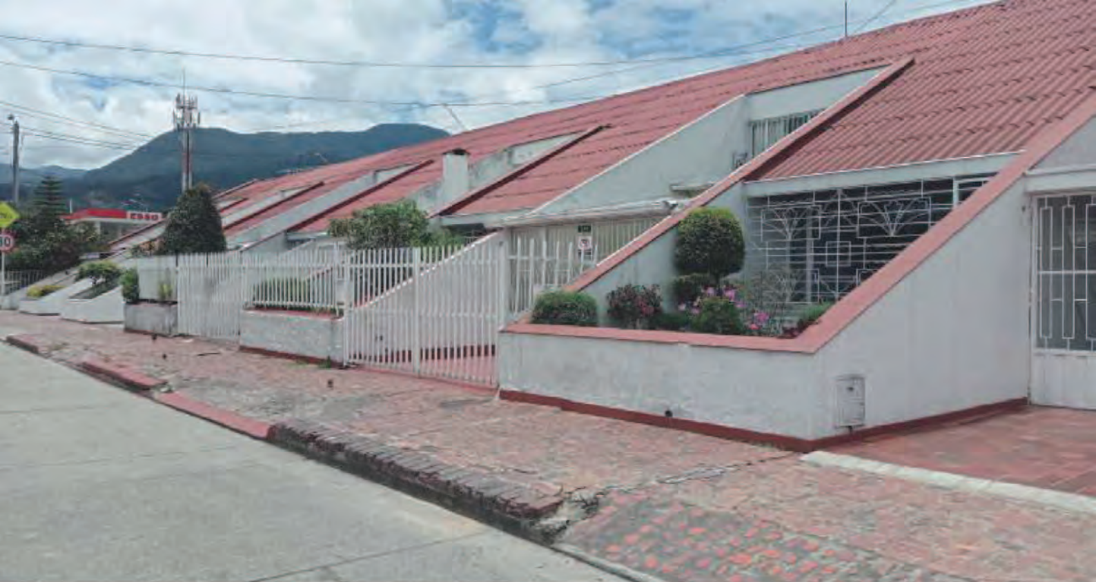
25b. Estado actual de las siete casas del costado sur, 2022. Imagen: John Jairo Ruiz Martínez.
